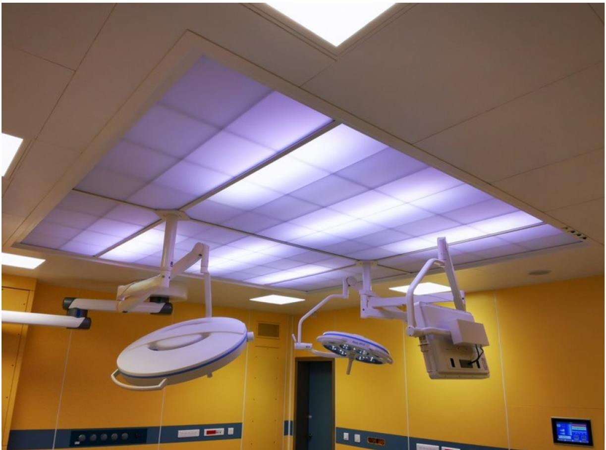
Figure 26 Éclairage de salle de bloc opératoire
