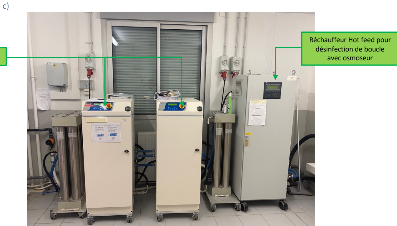
Osmoseur avec réchauffeur pour désinfection thermique
