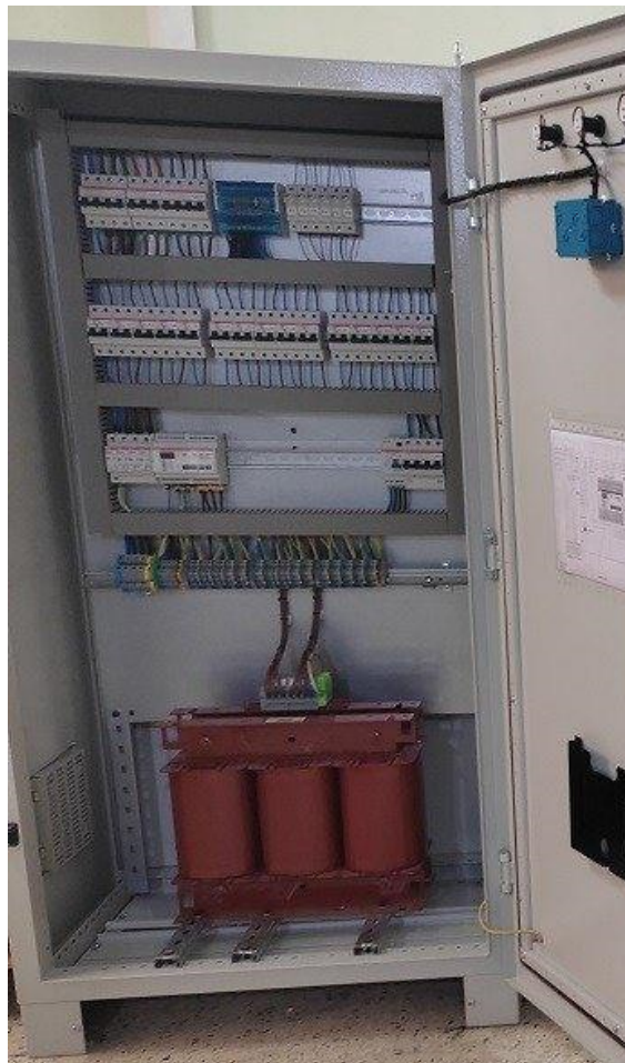
Figure 32 Armoire électrique régime IT
